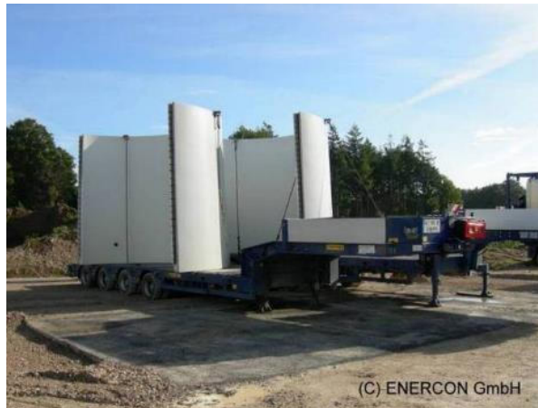
Figure 81 : Chargement d'un mat béton (Source : ENERCON)
